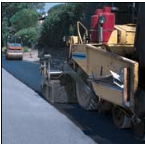
Stesa del conglomerato bituminoso.
