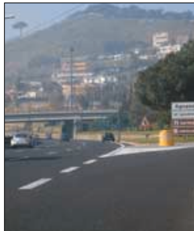
Svincolo di Agnano - Tappeto drenante Anno di esecuzione 2003
