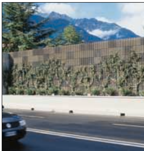
Barriere antirumore con elementi Leca sulla Tangenziale di Modena (sopra) e a Merano - BZ (sotto).
