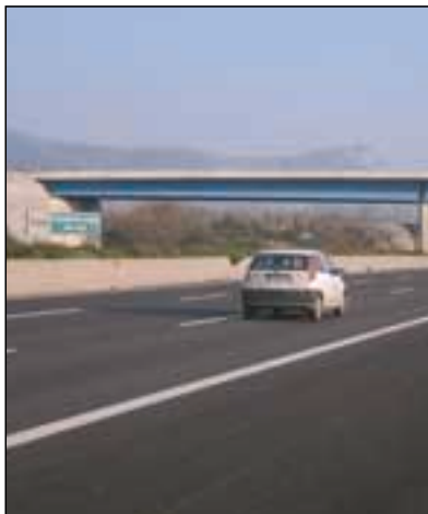
Autostrada Milano Napoli - Microtappeto Anno di esecuzione 2002/2003
