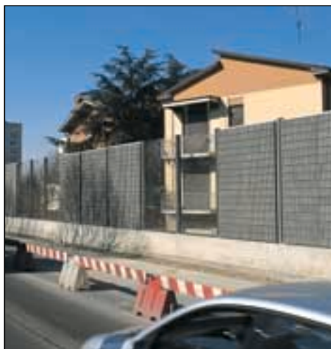
Barriere antirumore con elementi Leca sulla Tangenziale di Modena (sopra) e a Merano - BZ (sotto).
