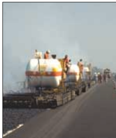
Autostrada Venezia Treviso. Riciclaggio in sito di tappeto drenante. Sistema Soave. Anno di esecuzione 1996/1997
