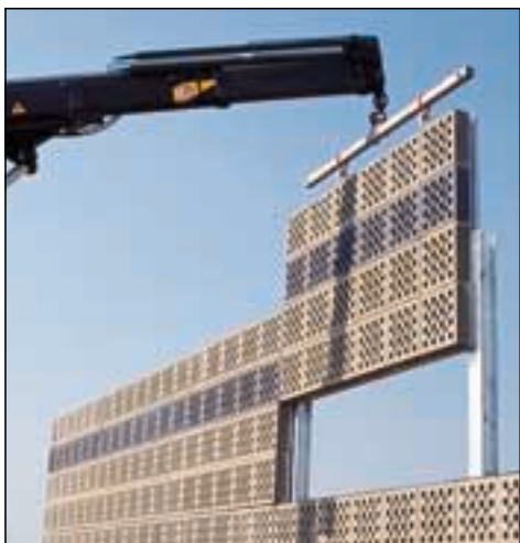
Montaggio di barriere antirumore con elementi Leca solidarizzati ad un pannello prefabbricato in calcestruzzo.
