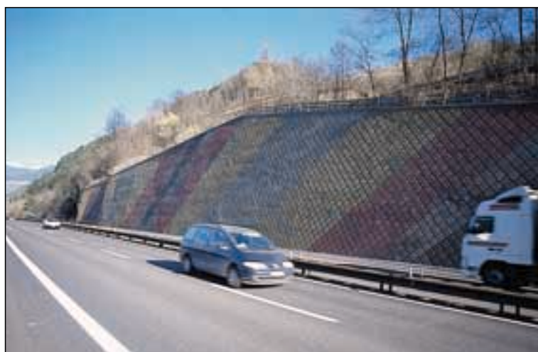
Barriera antirumore con elementi Leca di forme diverse per ottenere un effetto estetico personalizzato (Tangenziale di Milano).
