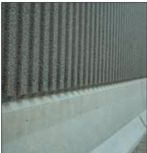
Montaggio di barriere antirumore con elementi Leca solidarizzati ad un pannello prefabbricato in calcestruzzo.
