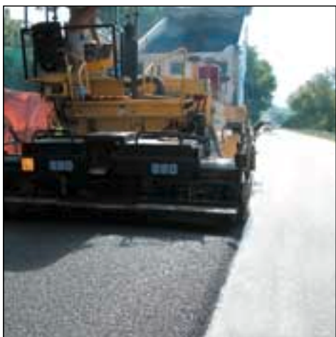
Stesa del conglomerato bituminoso.
