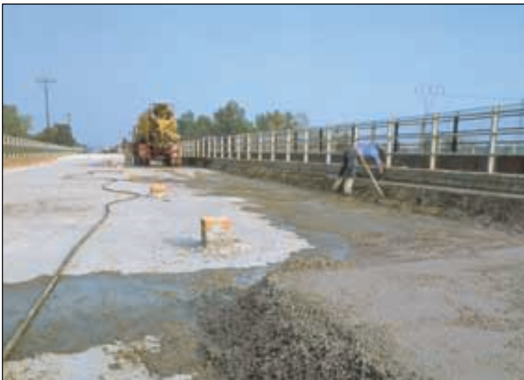
Rasamento di impalcato autostradale in conglomerato cementizio leggero di argilla espansa (Ponte sul Ticino - Autostrada Milano - Torino).
