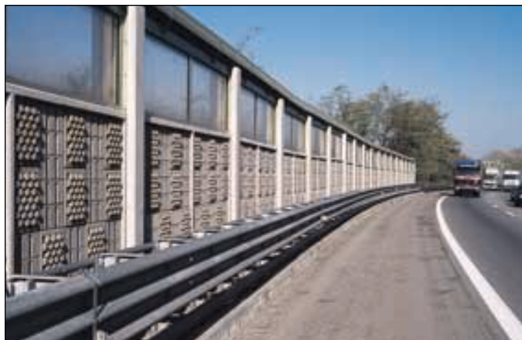
Barriera antirumore con elementi Leca di forme diverse per ottenere un effetto estetico personalizzato (Tangenziale di Milano).
