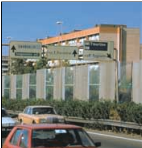
Barriere eseguite con pannelli di calcestruzzo Leca. Valori di assorbimento acustico \alpha compresi tra 0,40 e 0,50 a 500 Hz, e tra 0,45 e 0,70 a 1000 Hz.
