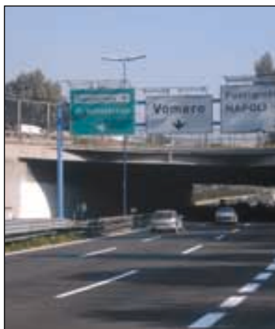
Tangenziale Napoli - Tappeto drenante Anno di esecuzione 2003
