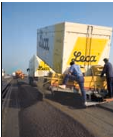
Autostrada Milano Bologna. Riciclaggio in sito di tappeto a struttura chiusa. Sistema ART-Marini. Anno di esecuzione 1993/1994
