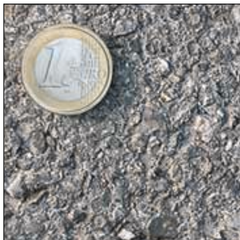
Superficie di pavimentazione fonoassorbente a struttura chiusa dopo tre anni di esercizio.
