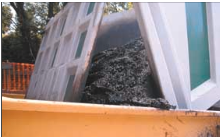
Conglomerato bituminoso in cantiere.
