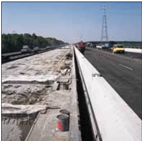
Calcestruzzo collaborante leggero di argilla espansa (densità 1500 Kg/m³). Ponte sul Po (PC) - Autostrada Milano - Bologna.
