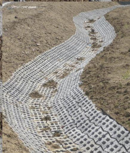
Sistema antierosivo pesante, flessibile e rinverdibile, con tutti i vantaggi dei sistemi tradizionali leggeri, per il rivestimento e la protezione dall'erosione di fossi di guardia e canali anche con forte pendenza, per la realizzazione di salti idraulici filtranti non tradizionali, del paramento di monte e valle di dighe in terra, di sponde di porticcioli turistici, di zavorre di condotte sottomarine, e per la protezione di pile di ponti ed opere marittime.
