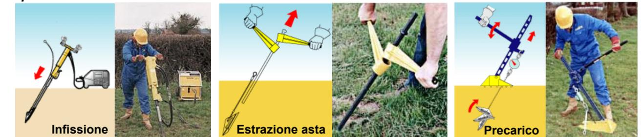
**IMPORTANTE:** Le ancore funzionano in maniera ottimale solo quando sono infisse all'adeguata profondità di installazione. Inoltre se le ancore non sono precaricate nella loro posizione di lavoro è altamente probabile che non funzioneranno come richiesto. A seconda della dimensione dell'ancora e della criticità dell'applicazione prevista l'entità di tali rischi può aumentare.
